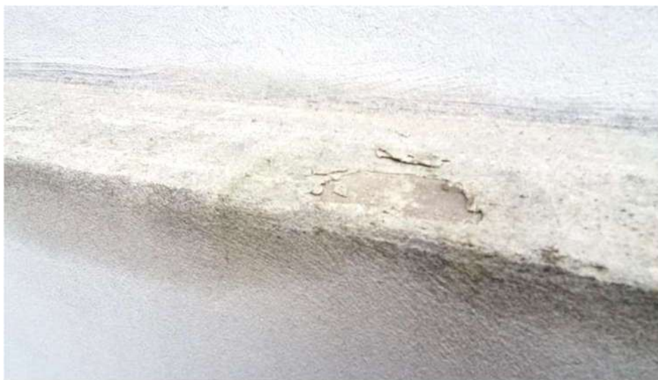
Fot. 9 Zawilgocenie w strefie cokołowej, odspojenie tynku, brak obróbki blacharskiej.
