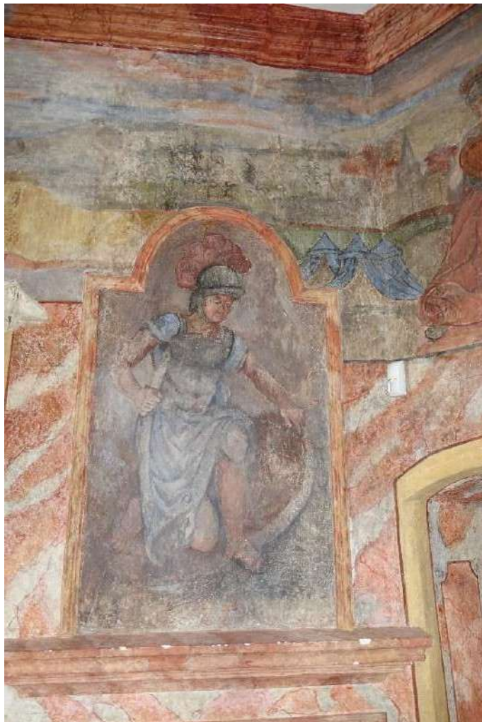
Fot. 2. Kasztel w Szymbarku. I p. alkierz pn.-zach., ściana wsch., polichromia XVIII w. , widoczne ubytki tynku na krawędziach, powierzchniowe zabrudzenia.
