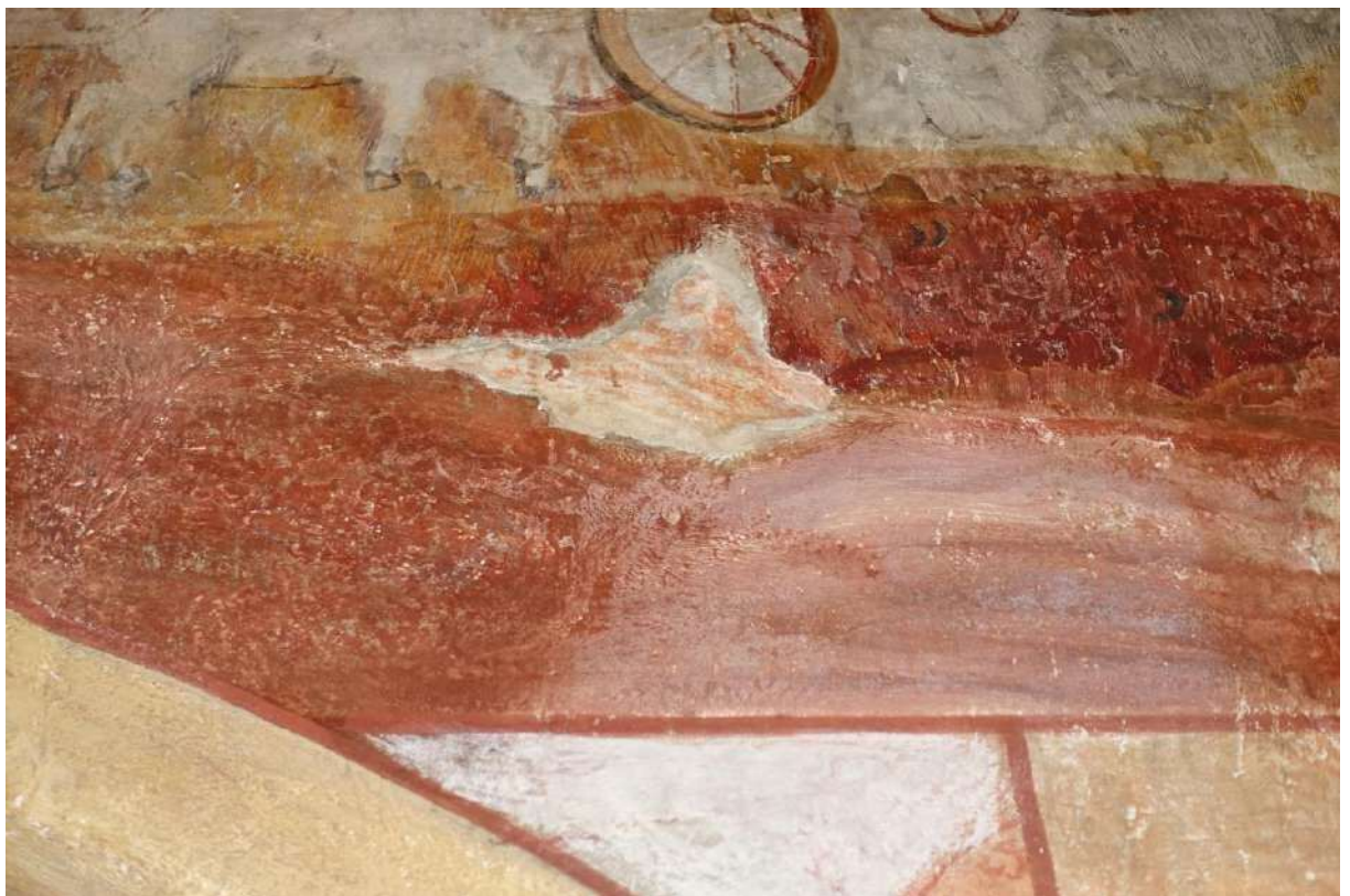
Fot. 10. Kasztel w Szymbarku. I p. alkierz płn.-zach., ściana płn., polichromia XVIII w., fragment, widoczny ubytek tynku i przetarcia malowidła.
