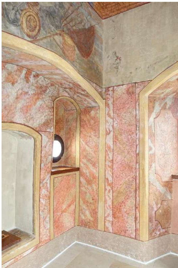
Fot. 20. Kasztel w Szymbarku. I p. alkierz półn.-zach., naroże połd.-zach., polichromia XVIII w., widoczne ubytki malowidła nad posadzką i zaplamienia.
