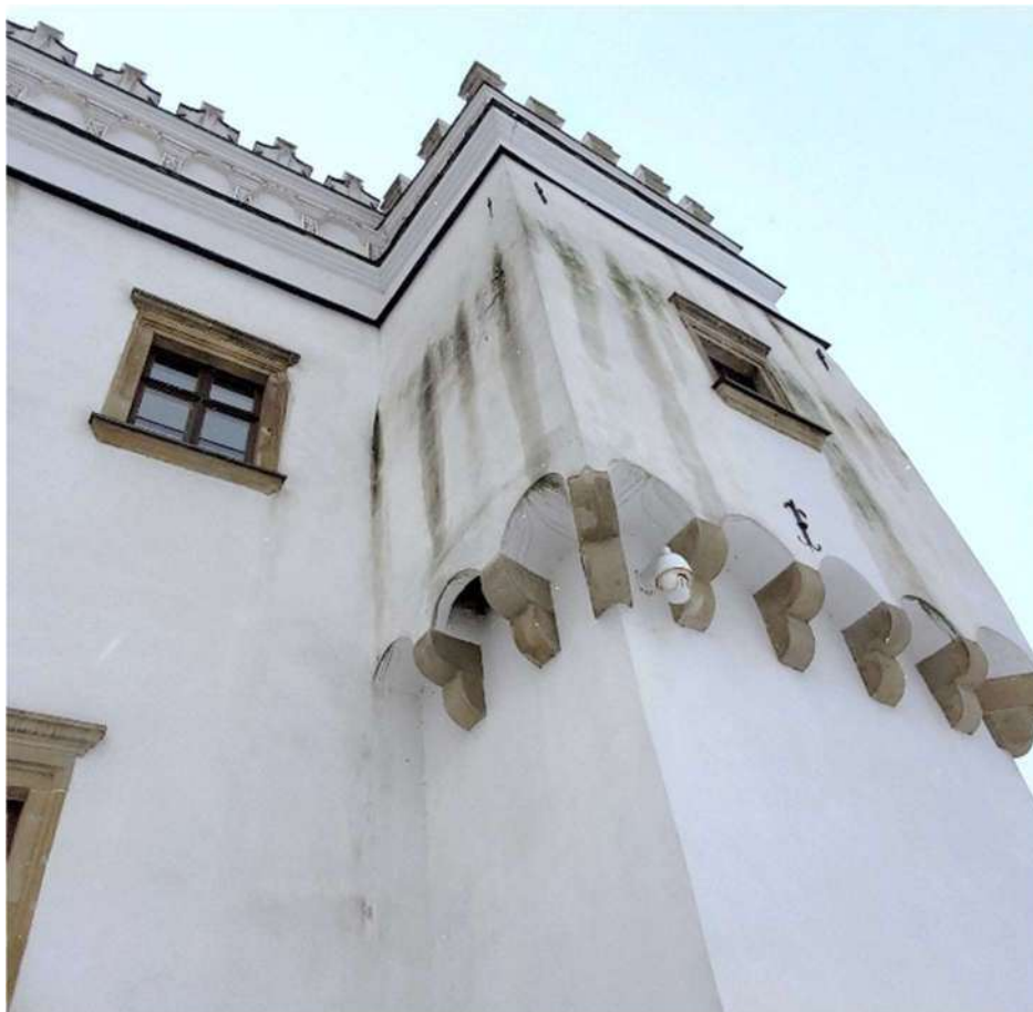
Fot. 8 Baszta na elewacji południowo-wschodniej z licznymi zaciekami, które powstały niewłaściwie wykonanymi obróbkami blacharskimi attyki i gzymsów.
