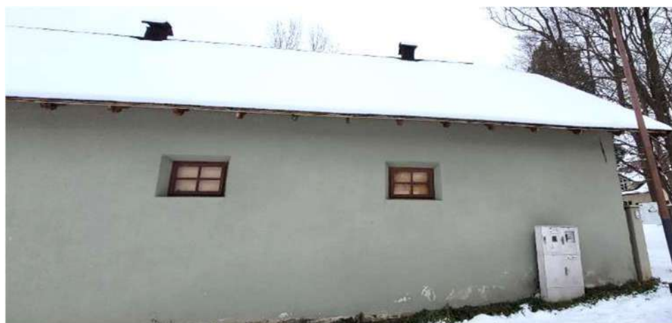
Fot. 20 Elewacja północno-wschodnia, widoczne zawilgoczenia i ubytki tynku w strefie cokołowej.
