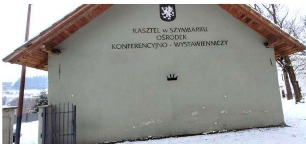
Fot. 19 Elewacja północno-zachodnia z widocznymi zawilgoczeniami i ubytkami tynku w strefie cokołowej.
