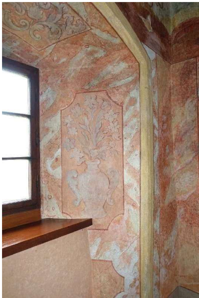
Fot. 8. Kasztel w Szymbarku. I p. alkierz płn.-zach., ściana płn., glif okienny, polichromia XVIII w., fragment, widoczne powierzchniowe zabrudzenia.
