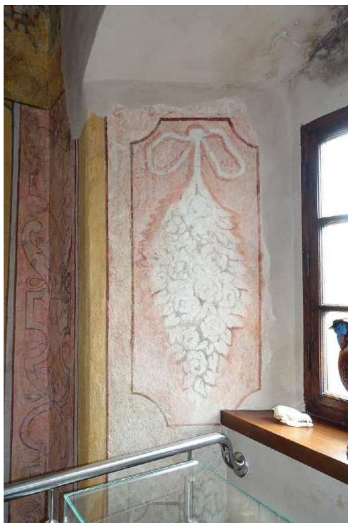
Fot. 28. Kasztel w Szymbarku. I p. alkierz płd.-zach., ściana płd., glif okienny, polichromia XVIII w., fragment, widoczne przetarcia malowidła i plamy zacieków.
