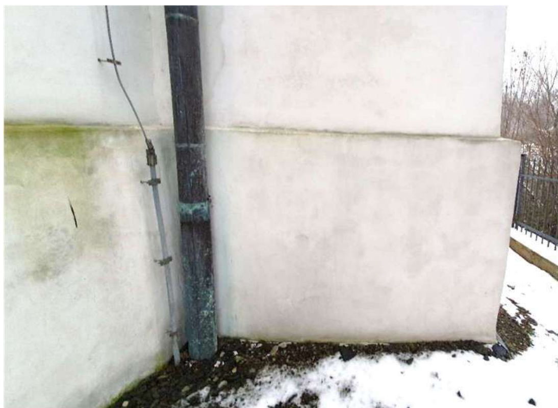
Fot. 15 Zawilgocenia i ślady glonów w strefie cokołowej na elewacji południowo-zachodniej.
