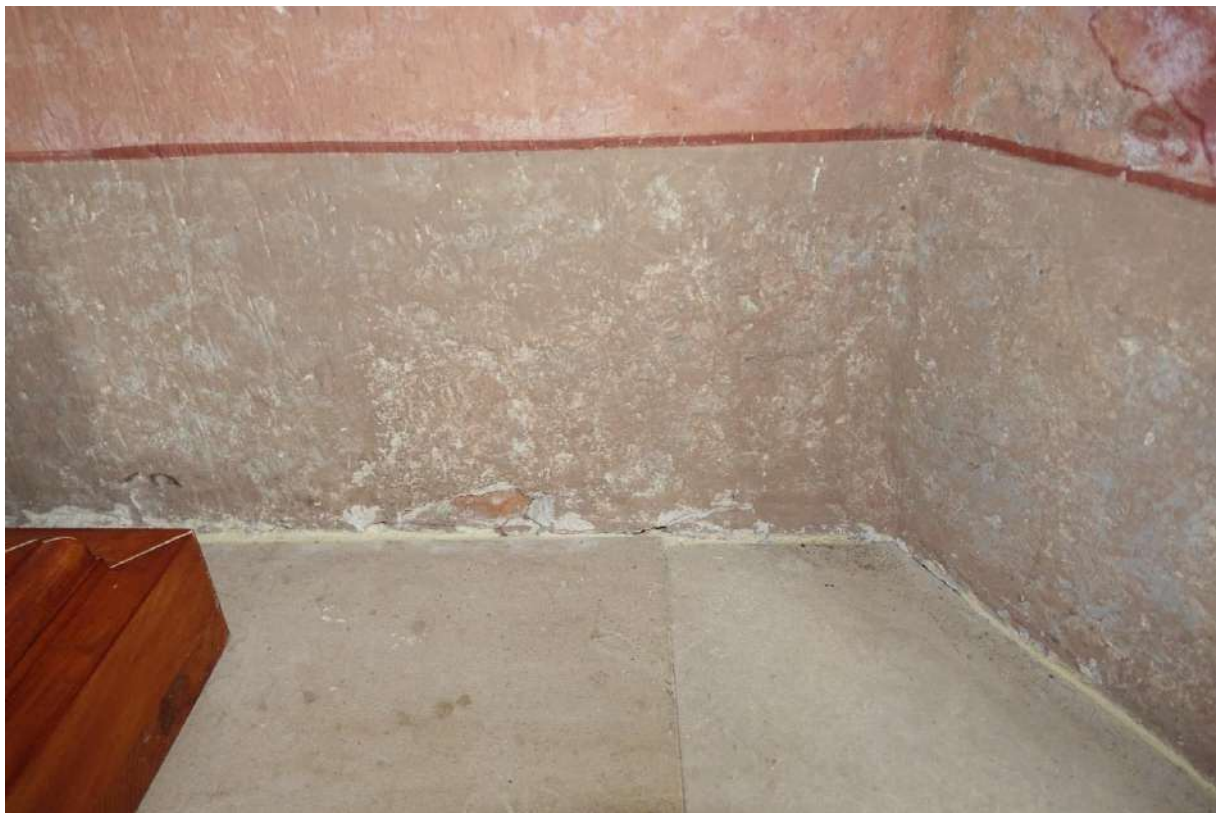
Fot. 17. Kasztel w Szymbarku. I p. alkierz pñ.-zach., ściana zach., gñif okienny, polichromia XVIII w., fragment, widoczne ubytki malowidła i tynku.
