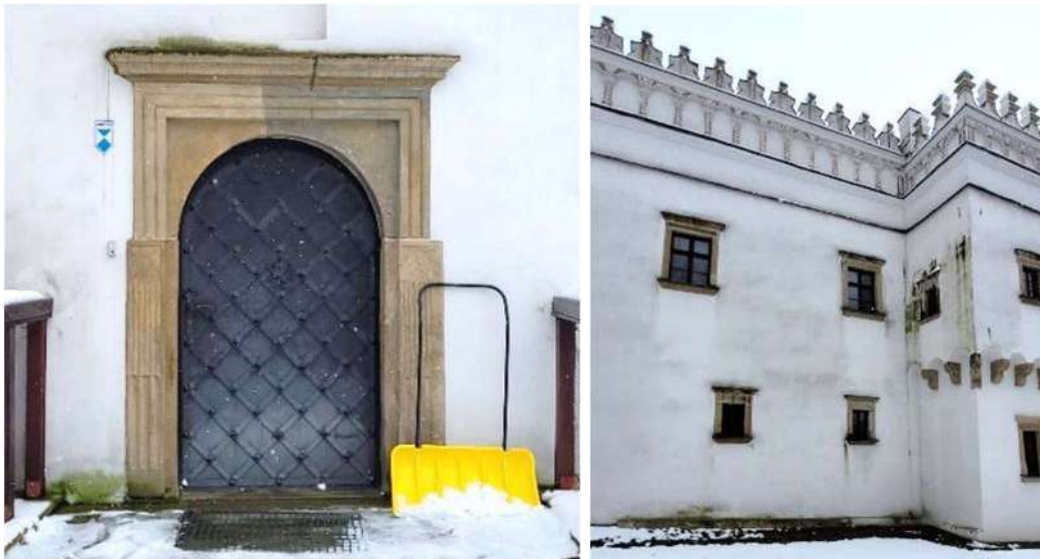
Fot. 2 Kamienny portal wejściowy z widocznymi zaciekami , śladami glonów oraz zawilgocenia w strefie cokołowej oraz wyższych partiach murów.
