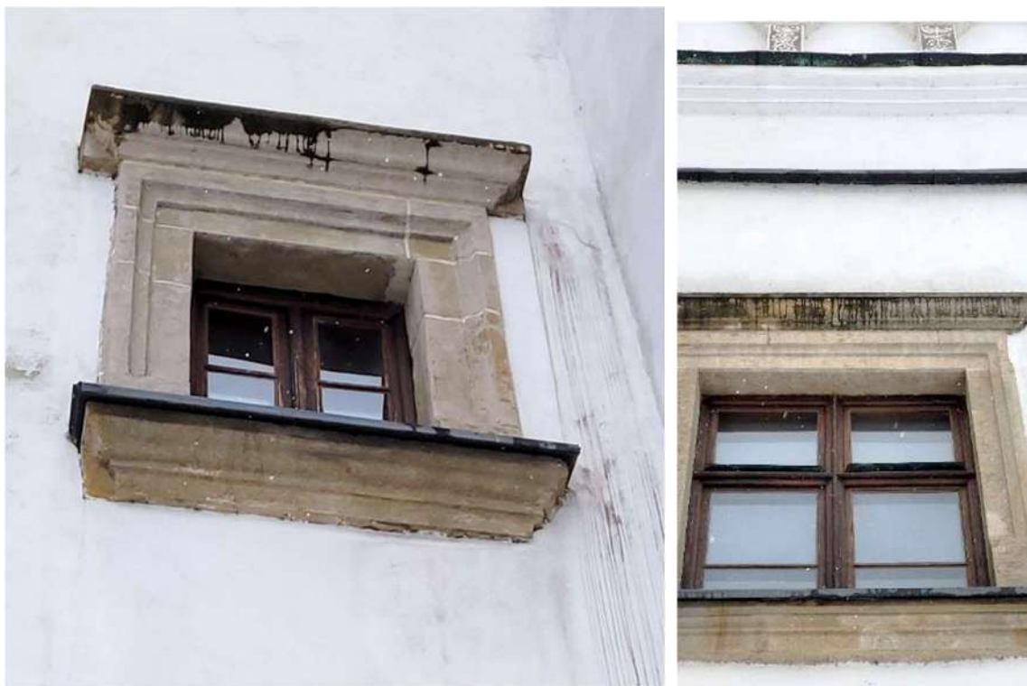
Fot. 17 Niewłaściwie wykonane obróbki blacharskie przy oknach oraz ich brak na gzymsie nadokiennym powodują powstawanie zacieków na elewacji.
