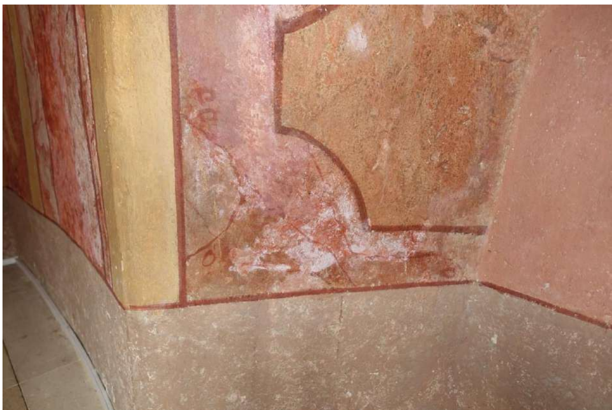
Fot. 16. Kasztel w Szymbarku. I p. alkierz płn.-zach., ściana zach., glif okienny, polichromia XVIII w., fragment, widoczne ubytki malowidła.
