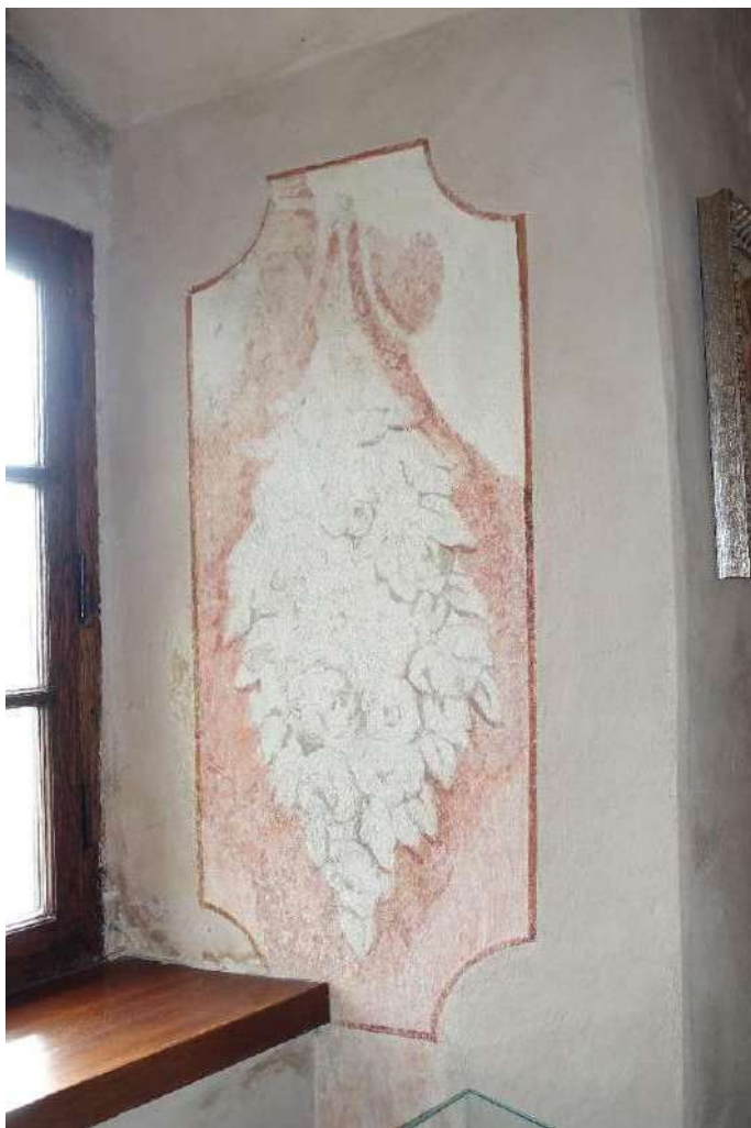
Fot. 29. Kasztel w Szymbarku. I p. alkierz pld.-zach., ściana pld., glif okienny, polichromia XVIII w., fragment, widoczne przetarcia malowidła, plamy zacieków i uszkodzenia tynku.
