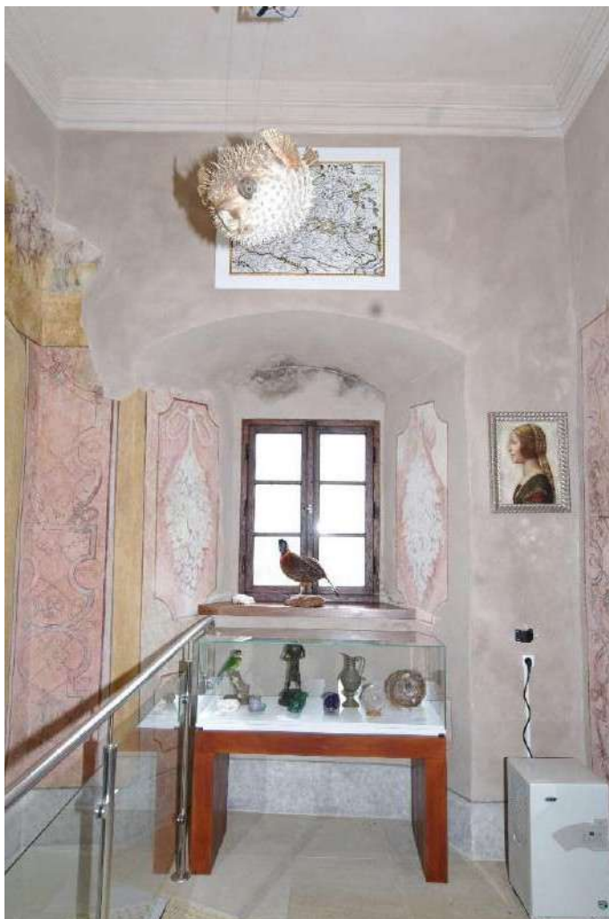
Fot. 27. Kasztel w Szymbarku. I p. alkierz płd.-zach., ściana wsch., polichromia XVIII w., widoczne nad oknem zacieki i uszkodzenie tynku.
