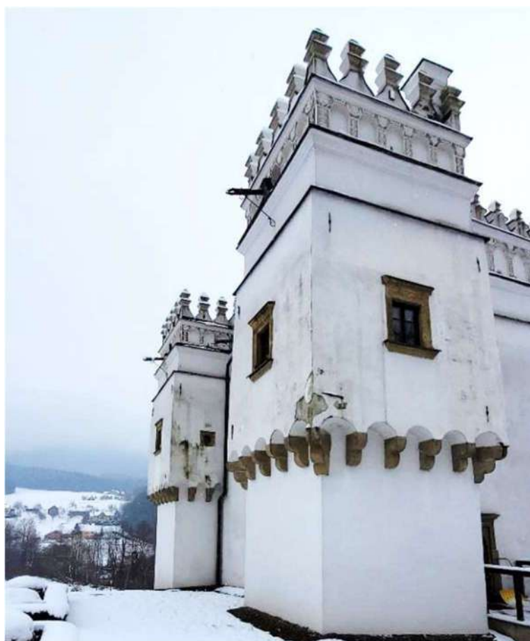
Fot. 3 Baszta w narożniku elewacji północno-wschodniej i północno-zachodniej, zauważalne ubytki tynku, liczne zacieki.
