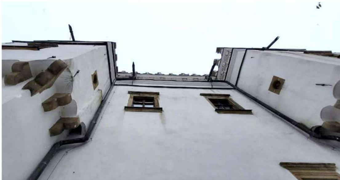
Fot. 14 Elewacja południowo-zachodnia, widoczne zawilgocenia i zacieki powstałe w wyniku niewłaściwie wykonanych obróbek blacharskich attyki i gzymsów.
