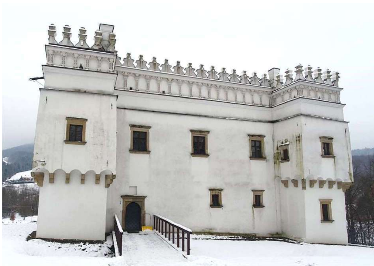
Fot. 1 Elewacja północno-zachodnia. Widoczne liczne ślady zawilgoceń i glonów, zacieków na murach i obróbce kamieniarskiej, ubytki tynku.
