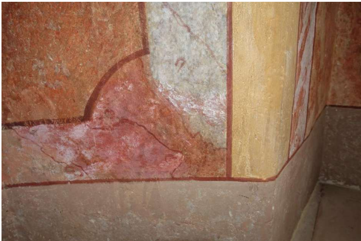
Fot. 15. Kasztel w Szymbarku. I p. alkierz płn.-zach., ściana zach., glif okienny, polichromia XVIII w., fragment, widoczne ubytki malowidła.
