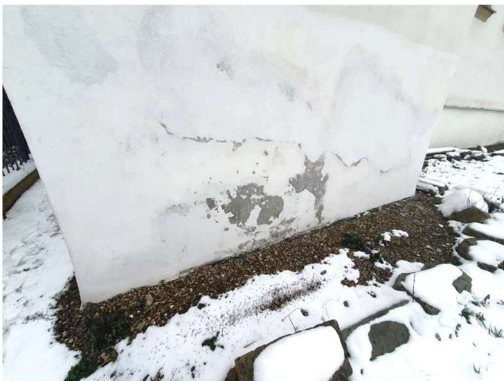
Fot. 11 Ubytki i zawilgocenia tynku w strefie cokołowej na elewacji południowo-wschodniej.
