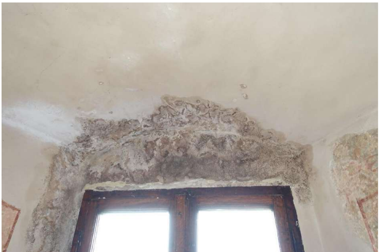
Fot. 34. Kasztel w Szymbarku. I p. alkierz pld.-zach., ścian zach., nadproże glifu okiennego, polichromia XVIII w., fragment, widoczne plamy zacieków i uszkodzenia tynku.
