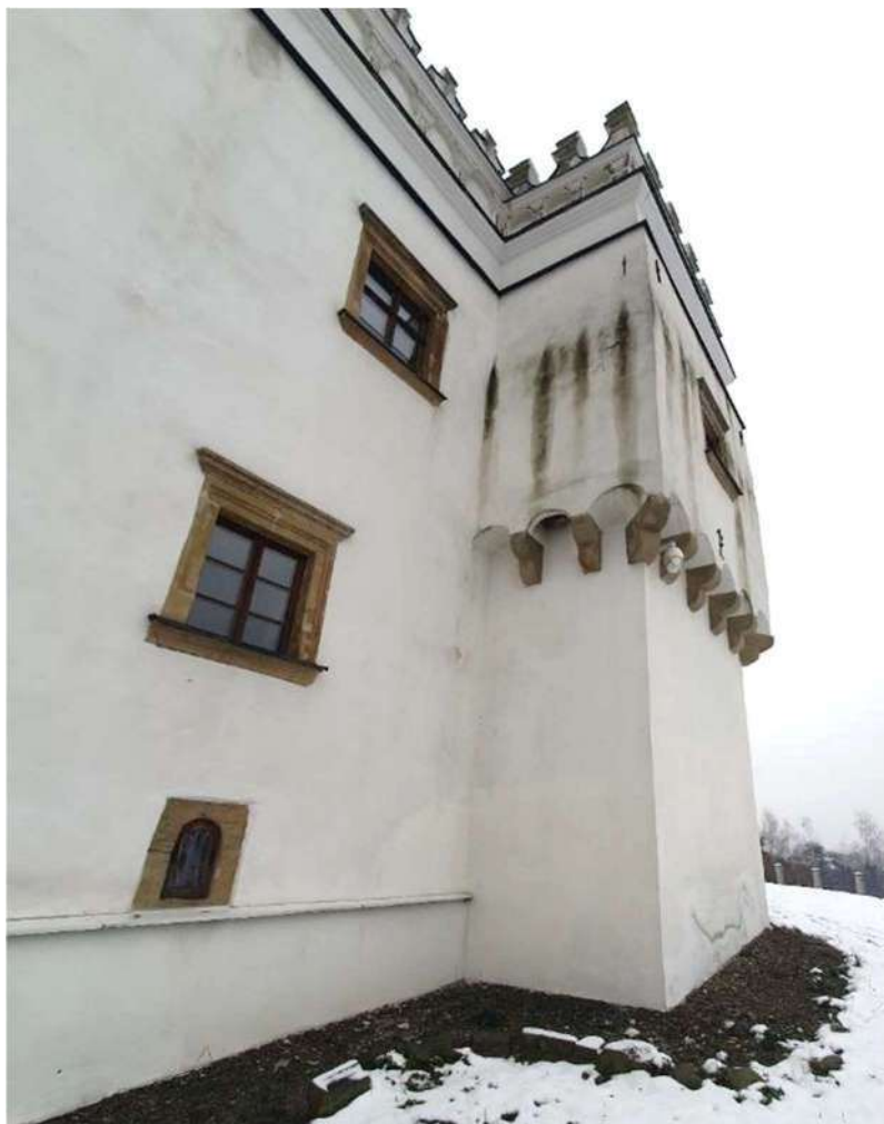
Fot. 12 Elewacja południowo- wschodnia z zaciekami spowodowanymi niewłaściwie wykonaną obróbką blacharską attyki i gzymsów.
