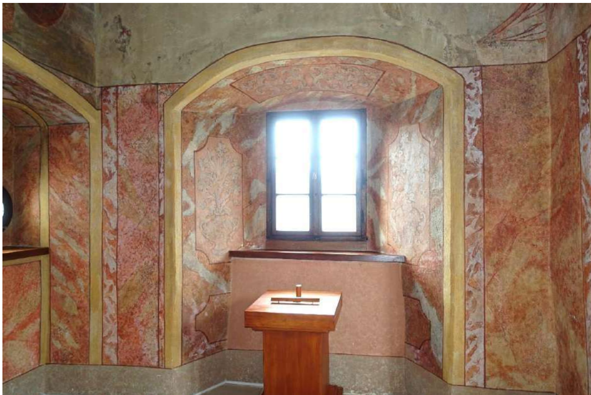
Fot. 11. Kasztel w Szymbarku. I p. alkierz płn.-zach., ściana zach., polichromia XVIII w., widoczne ubytki malowidła nad parapetem i posadzką, zaplamienia powierzchni. Fot. M. Sawicki 2024 r.
