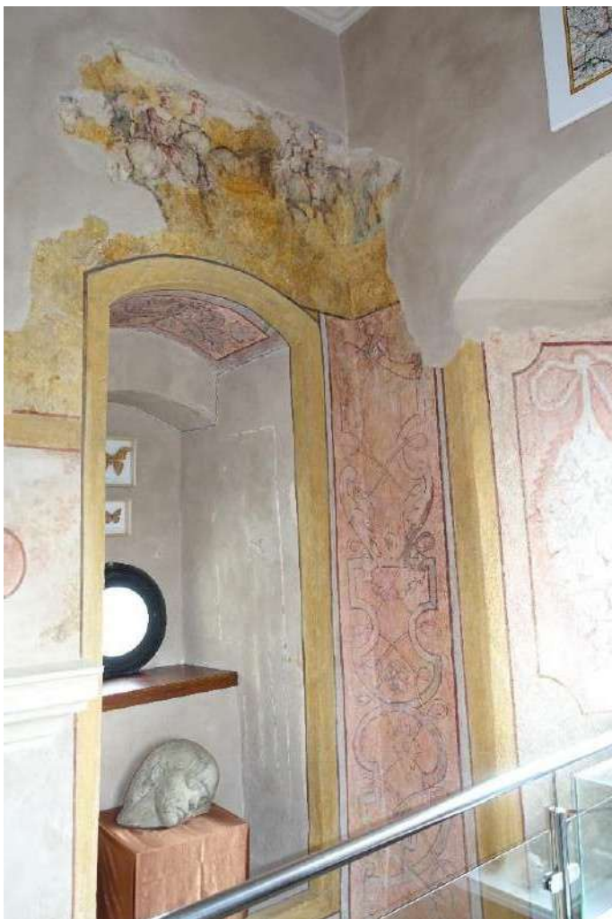
Fot. 24. Kasztel w Szymbarku. I p. alkierz pld.-zach., naroże pld.- wsch., polichromia XVIII w., fragment, widoczne przetarcia i zacieki. Fot. M. Sawicki 2024 r.
