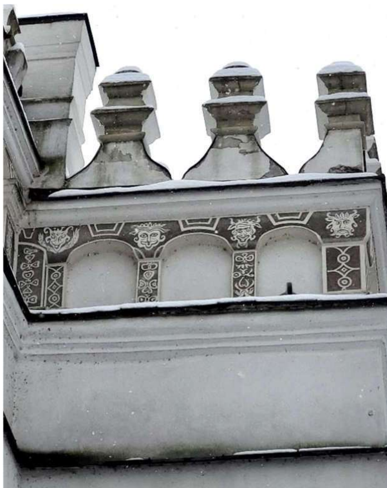
Fot. 6 Spękania i ubytki tynku na sterczynach. Przeprowadzony jakiś czas temu remont sterczyn został wykonany tylko w zakresie obróbek blacharskich bez odnowienia ich otynkowanych płaszczyzn. Widoczne zawilgocenia spowodowane źle wykonaną obróbką blacharską attyki i gzymsów. Prace w zakresie sgraffita prowadzone były w trakcie remontu elewacji w 2010 r.
