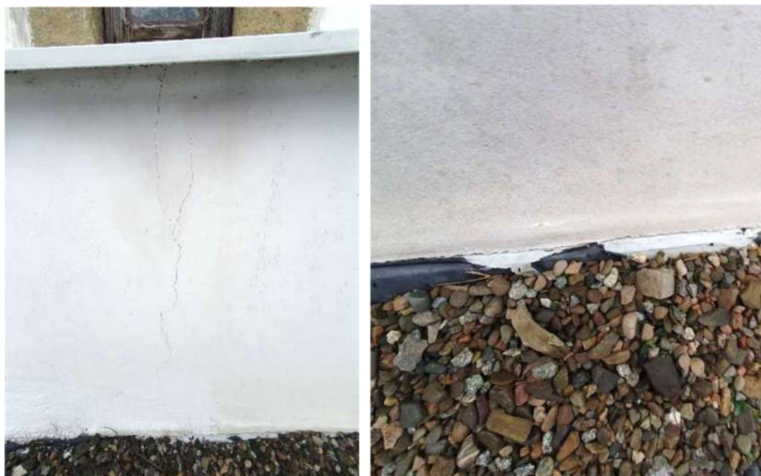
Fot. 13 Pęknięcia w tynku w strefie cokołowej oraz odsłonięta izolacja na ścianie elewacji południowo-wschodniej.
