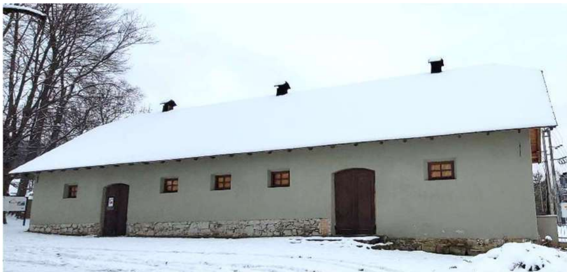
Fot. 18 Elewacja południowo-zachodnia z widocznymi odspojeniami tynku w strefie cokołowej.
