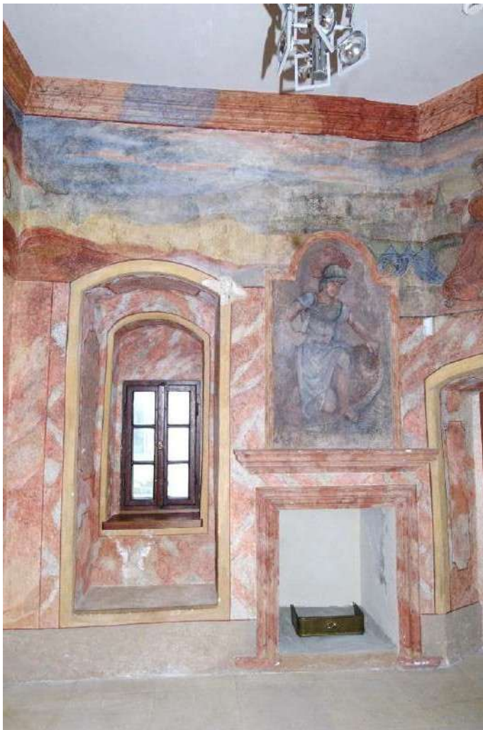
Fot. 1. Kasztel w Szymbarku. I p. alkierz pñ.-zach., ściana wsch., polichromia XVIII w. , widoczne ubytki tynku na krawędziach.
