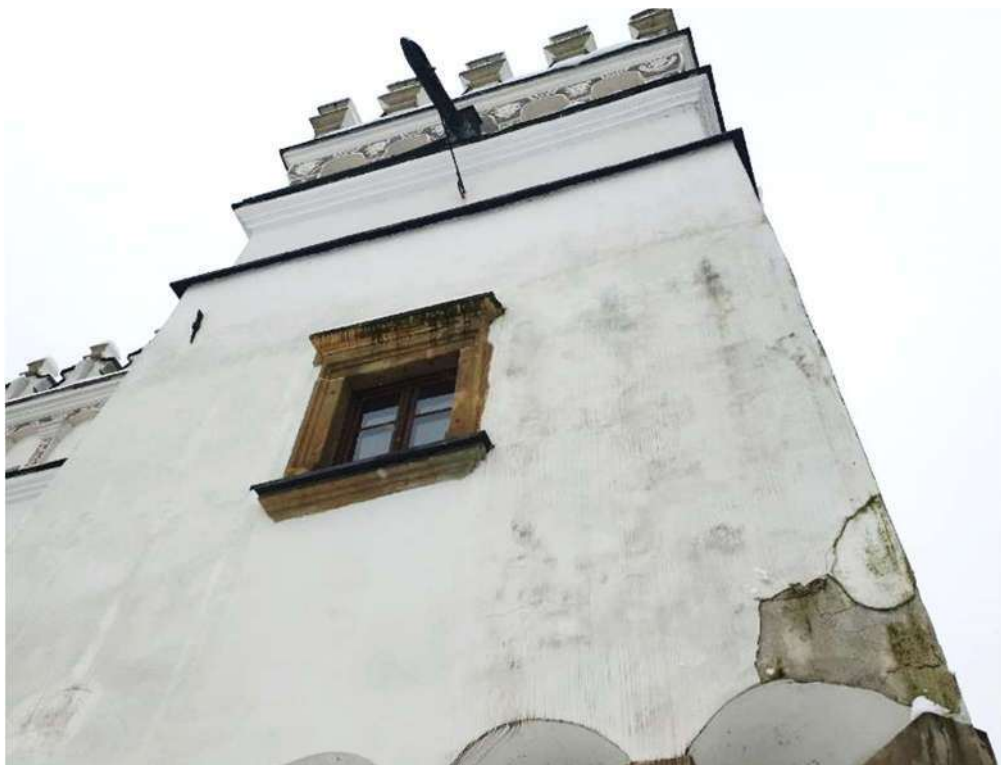
Fot. 10 Baszta na elewacji północno-wschodniej z zaciekami na elewacji otynkowanej oraz elementach kamiennych wokół okien ( niewłaściwie wykonana obróbka blacharska gzymsów oraz brak obróbki na gzymsie nadokiennym powodują zniszczenia na elewacji).
