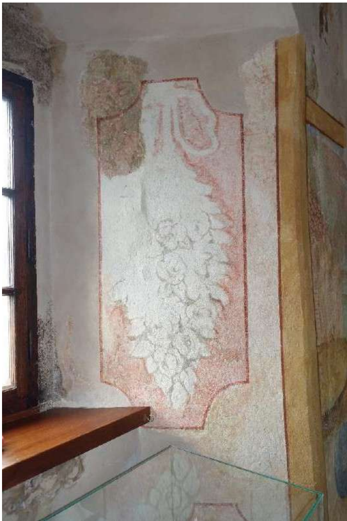
Fot. 33. Kasztel w Szymbarku. I p. alkierz pld.-zach., ścian zach., glif okienny, polichromia XVIII w., fragment, widoczne przetarcia malowidła, plamy zacieków i uszkodzenia tynku.
