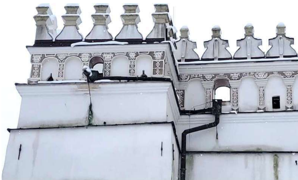
Fot. 5 Elewacja północno-wschodnia, strefa attyki i gzymsów- zauważalne zawilgocenia powstałe w wyniku źle wykonanych obróbek blacharskich attyki z dekoracją sgraffitową i gzymsów; obróbki z patynującej blachy miedzianej powodują zacieki.
