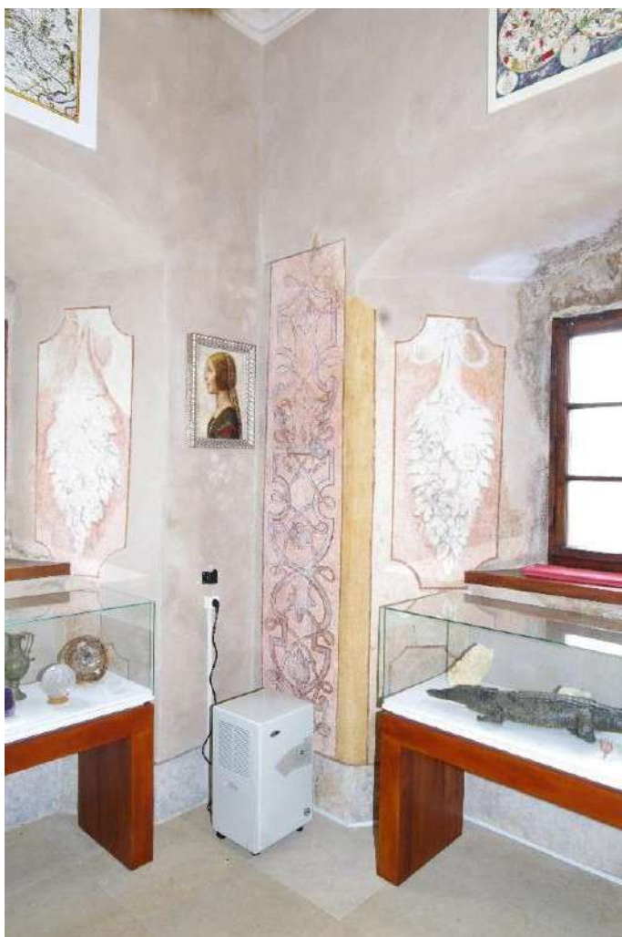
Fot. 30. Kasztel w Szymbarku. I p. alkierz pld.-zach., naroże pld.- zach., polichromia XVIII w., fragment, widoczne zacieki i uszkodzenia tynku wokół okna, zabrudzenia powierzchni ścian. uszkodzenia tynku.
