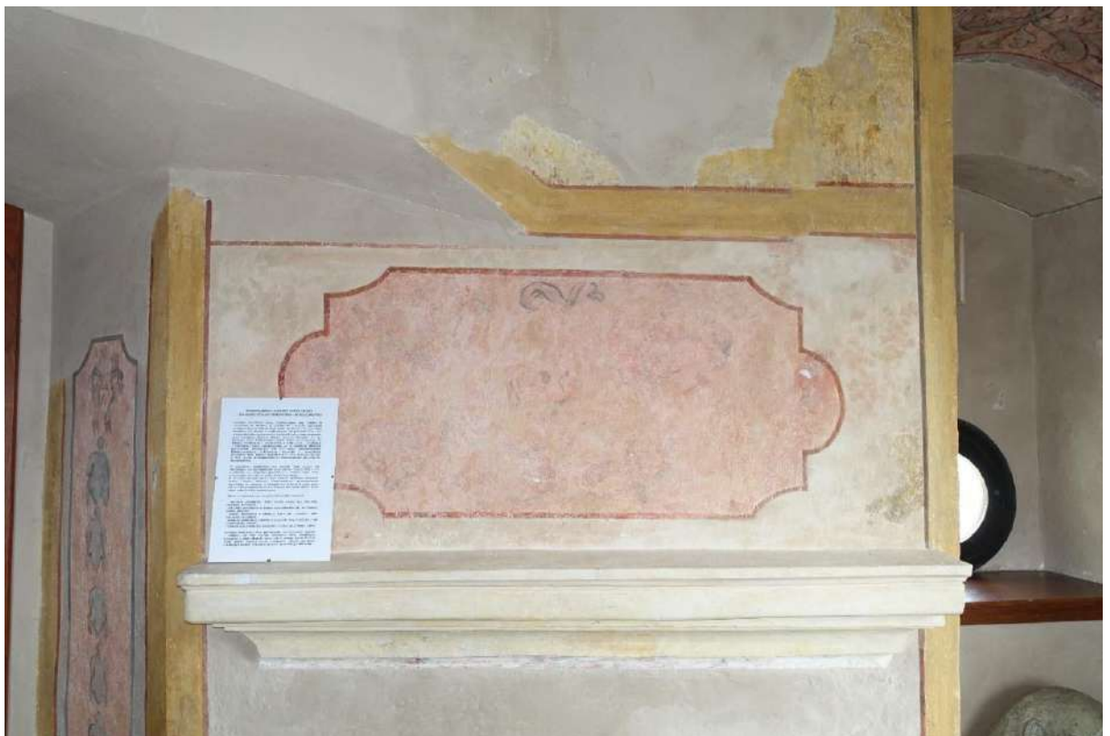
Fot. 26. Kasztel w Szymbarku. I p. alkierz pld.-zach., ściana wsch., polichromia XVIII w., fragment, widoczne przetarcia malowidła.
