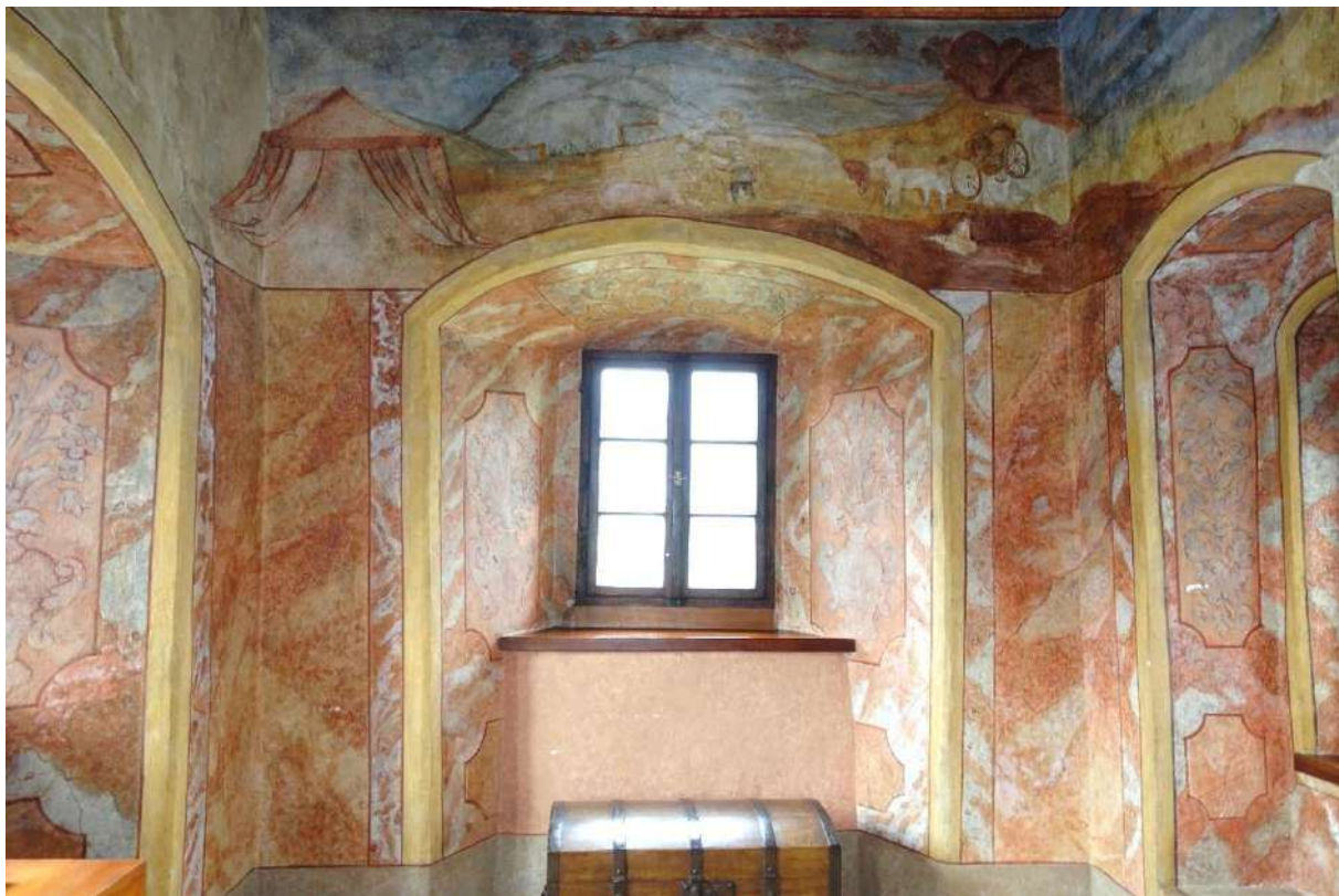
Fot. 5. Kasztel w Szymbarku. I p. alkierz płn.-zach., ściana płn., polichromia XVIII w., widoczne ubytki malowidła przy posadzce i nad parapetem.
