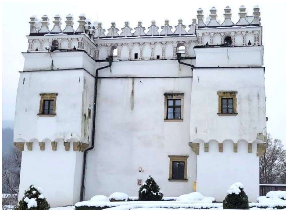
Fot. 4 Elewacja północno-wschodnia- ubytki tynku oraz liczne zawilgocenia murów.
