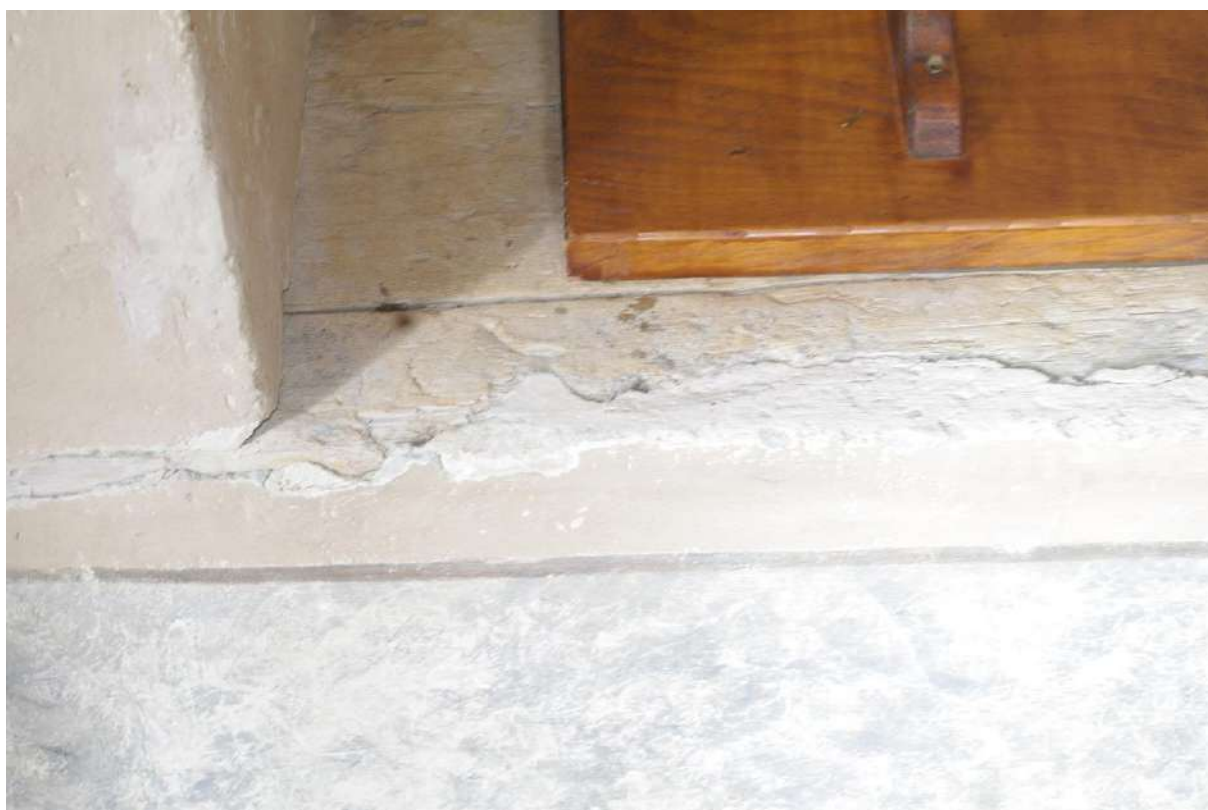
Fot. 38. Kasztel w Szymbarku. I p. alkierz pld.-zach., ściana płn., fragment, widoczne ubytki tynku.
