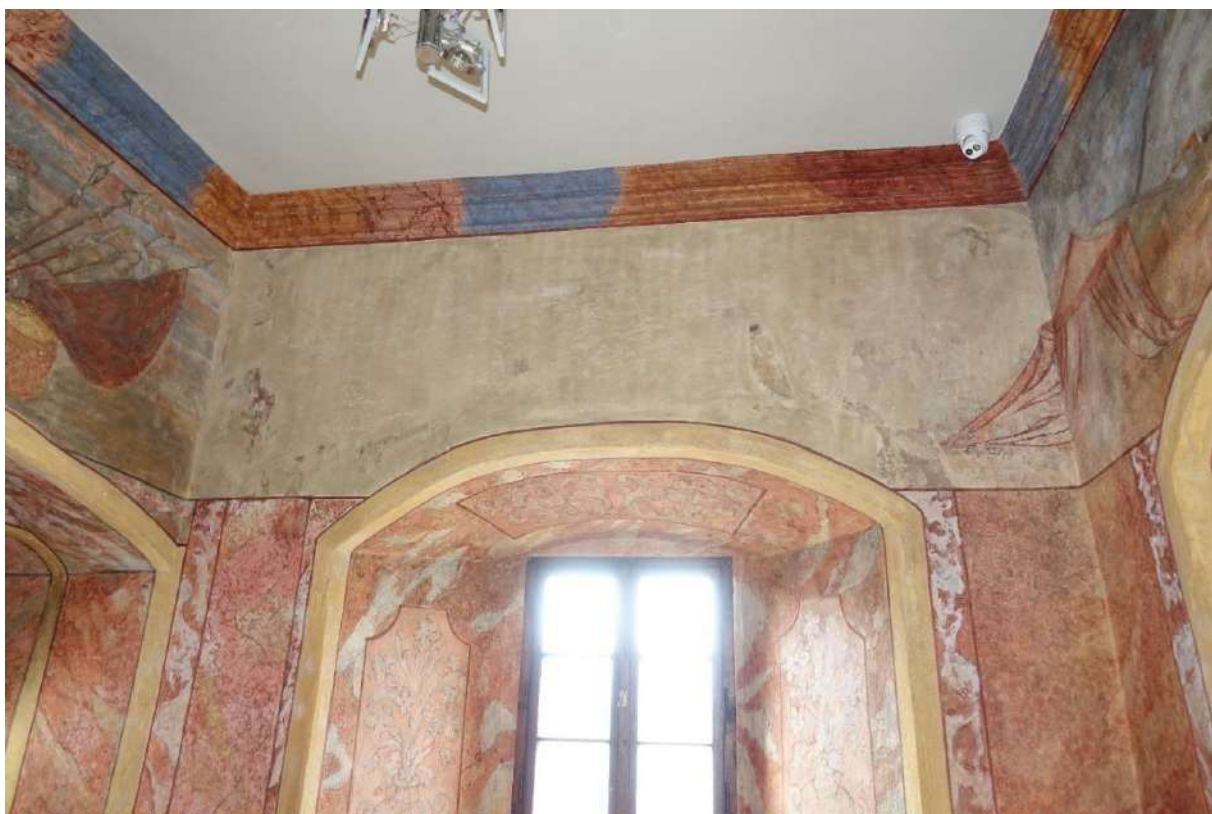
Fot. 12. Kasztel w Szymbarku. I p. alkierz płn.-zach., ściana zach., polichromia XVIII w., widoczne powierzchniowe zabrudzenia. Fot. M. Sawicki 2024 r.
