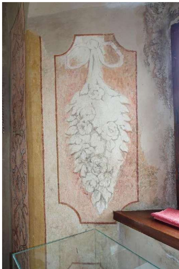
Fot. 32. Kasztel w Szymbarku. I p. alkierz płd.-zach., ścian zach., glif okienny, polichromia XVIII w., fragment, widoczne plamy zacieków i uszkodzenia tynku, przetarcia malowidła.
